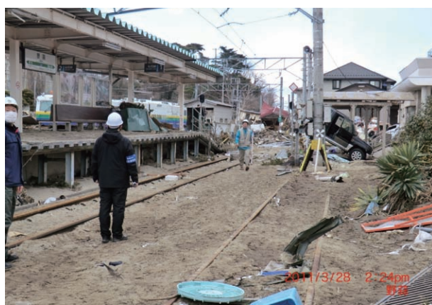
自然災害研究協議会による2011年東北太平洋沖地震津波調査 Field survey on tsunami damage by the 2011 off the Pacific Coast of Tohoku Earthquake
