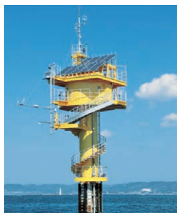
白浜・高潮観測塔 Observation Tower at Shirahama
