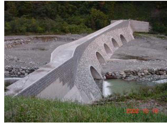
大暗渠砂防堰堤
