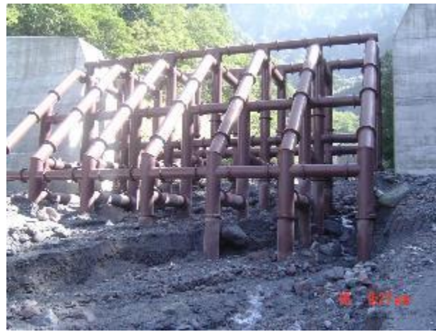
格子型砂防堰堤
