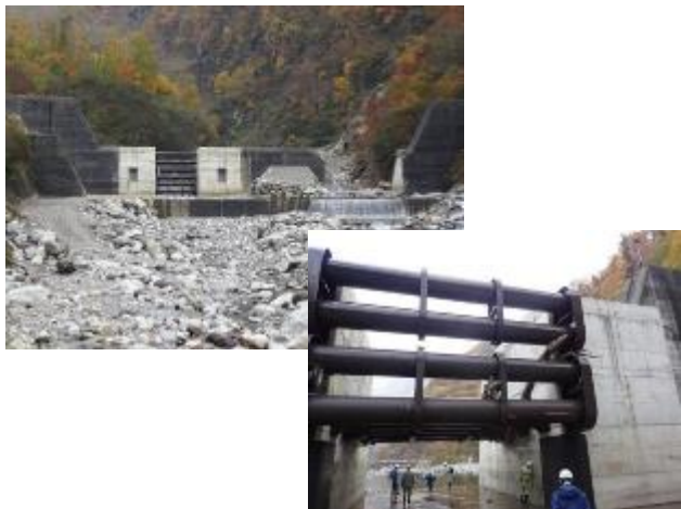
シャッター付き砂防堰堤
