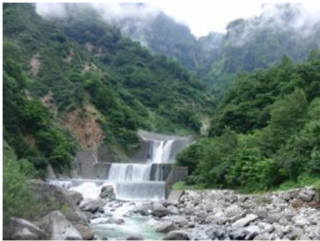
不透過型砂防堰堤
