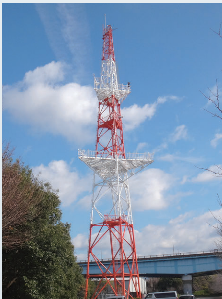
写真1 気象観測塔全景
