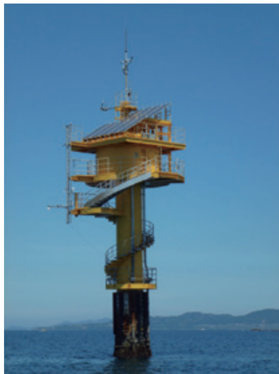
図1 白浜海象観測所、田辺中島高潮観測塔（塔体の太くなっている部分が計測室、海面上12.5m）
