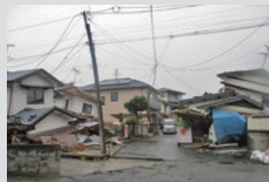
2016年熊本地震による建物被害
