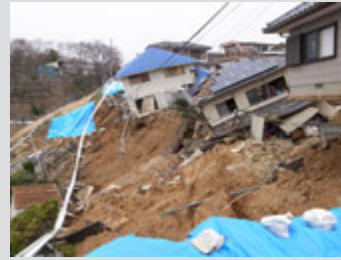
2011年東北地方太平洋沖地震によって発生した地すべりと住宅の被害 Collapse of housing lot by landslide induced by the 2011 Tohoku Earthquake
