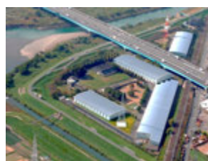
宇治川オープンラボラトリー全景 Aerial photo of Ujigawa Open Laboratory
