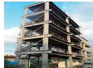
A-3鋼構造実大試験架構
