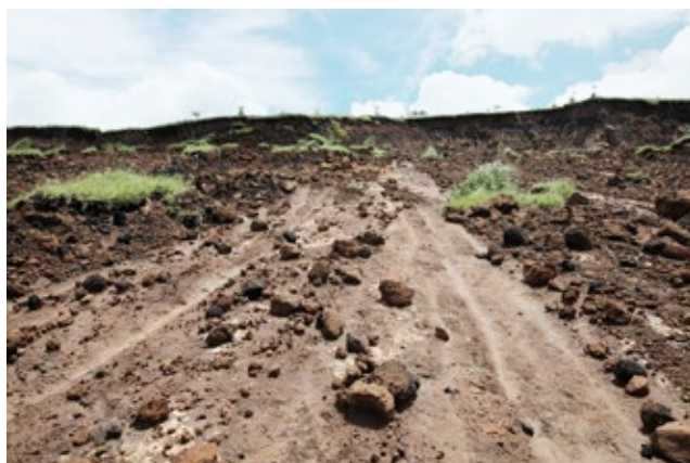
2016年熊本地震によって発生した地すべりの 頭部に露出したすべり面 Slip surface of a landslide induced by the 2016 Kumamoto earthquake
