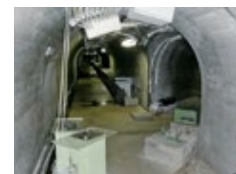
宮崎観測所の観測坑内における地殻変動観測 Crustal deformation measurement in the observation tunnel of Miyazaki Observatory
